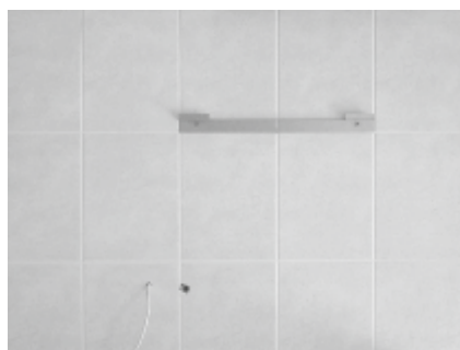
Beispiel für die Vorbereitung des Stromanschlusses, des Kondenswasserabflusses und der Konsolemontage.
